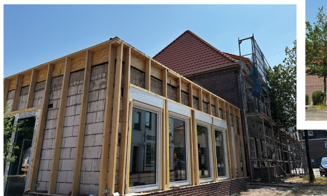
Abriss (oben links): Die Steintreppe soll Geschichte werden.
